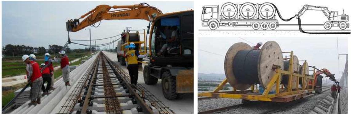
그림 1, 철도용 전력케이블의 기존 설치 과정
